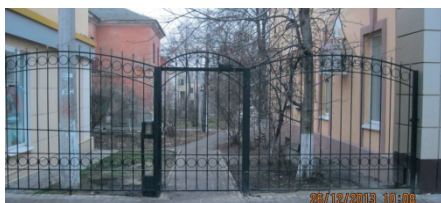
Ограждение и калитка с автоматическим приводом со стороны Белгородского проспекта
