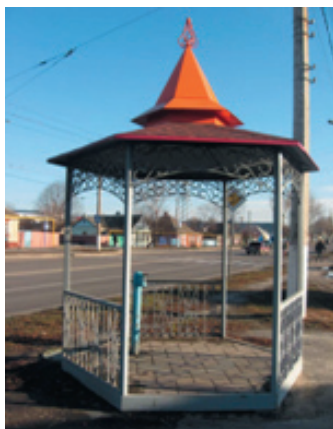
Совет территории № 23 (председатель СТ- Рязанов В.М.) Место расположения: ул.Волчанская; ул.Корочанская (частный сектор) Описание проекта: Установка 14 беседок для водоразборных колонок, выполнение устройства для стока воды. Мощение тротуарной плиткой основания беседок
