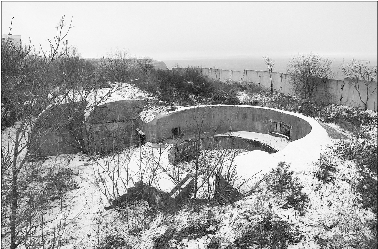
Батарея № 921. Дворик второго орудия и силовая, оборудованная в старом погребе. Фото Ю.В.Иванова
