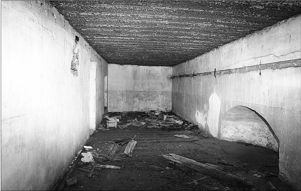
Батарея № 921. Правый погреб боезапаса, построенный на базе незаконченного и законсервированного старого погреба. Видна стена с нишей, оставшаяся от старых конструкций. Фото Ю.В. Иванова
