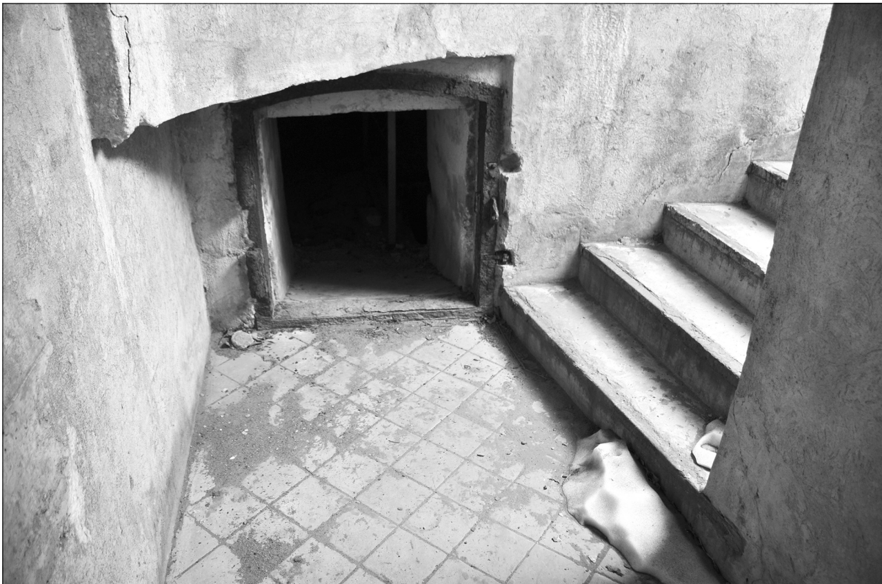
Батарея № 922. Окно подгачи зарядов в сквозник. Фото Ю.В. Иванова
