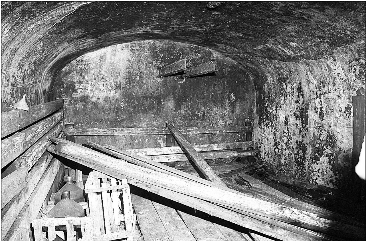
Батарея № 921. Интерьер силовой. Фото Ю.В. Иванова
