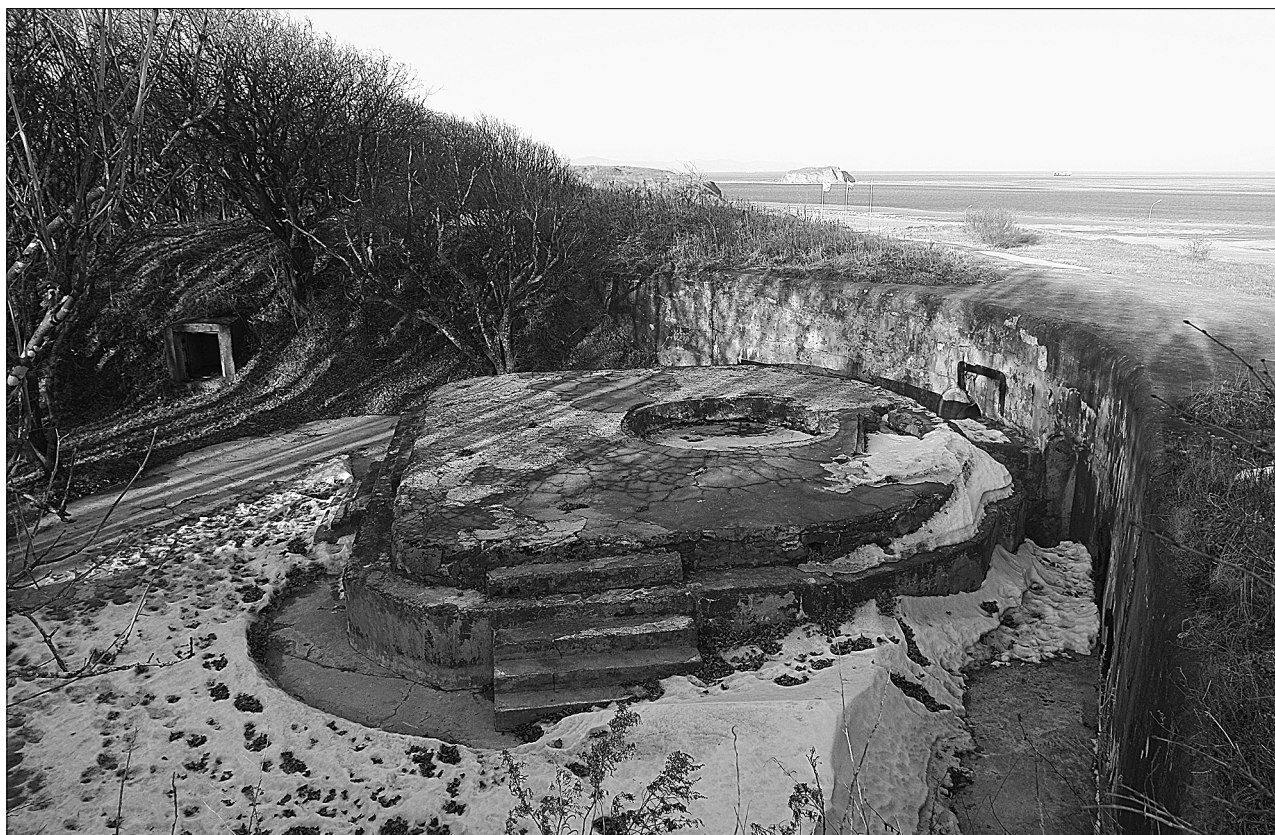
Батарея № 922. Орудийный дворики с основанием 152-мм модернизированной пушки Канэ. В земляной траншеи врезана железобетонная ниша для хранения первых выстрелов. Фото Ю.В. Иванова
