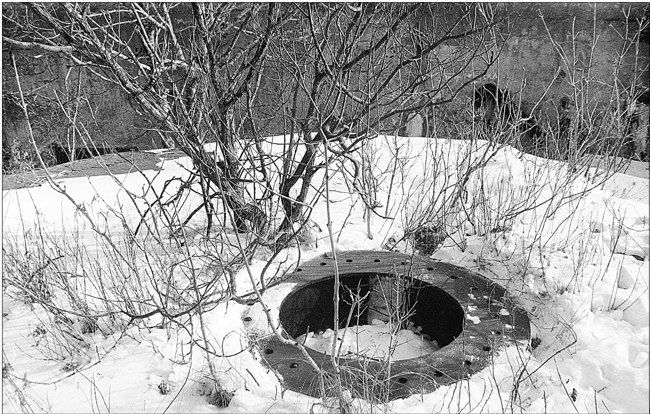
Батарея № 922. Переходный барабан для установки 130-мм пушки Б-13 на основании 152-мм модернизированной пушки Канэ. Фото Ю.В. Иванова
