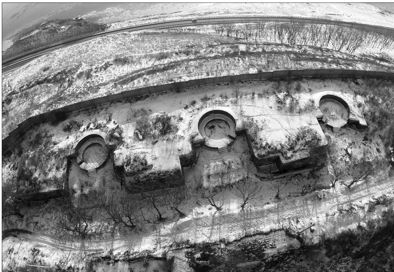
Огневая позиция батареи № 921. Вид с высоты птичьего полета. Видны погреба, силовая (в центре) и три орудийных дворика, 152-мм/45 кал./60° пушки Канэ демонтированы. Фото С.С. Орлова
