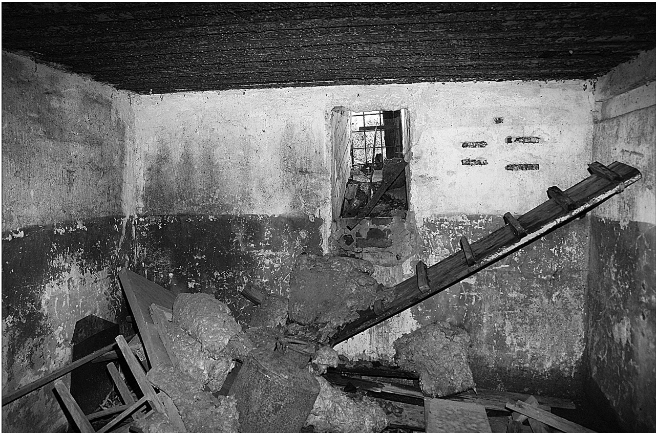
Батарея № 921. Погреб боезапаса на левом фланге (новый). Окно для подачи выстрелов к третьему орудью.
