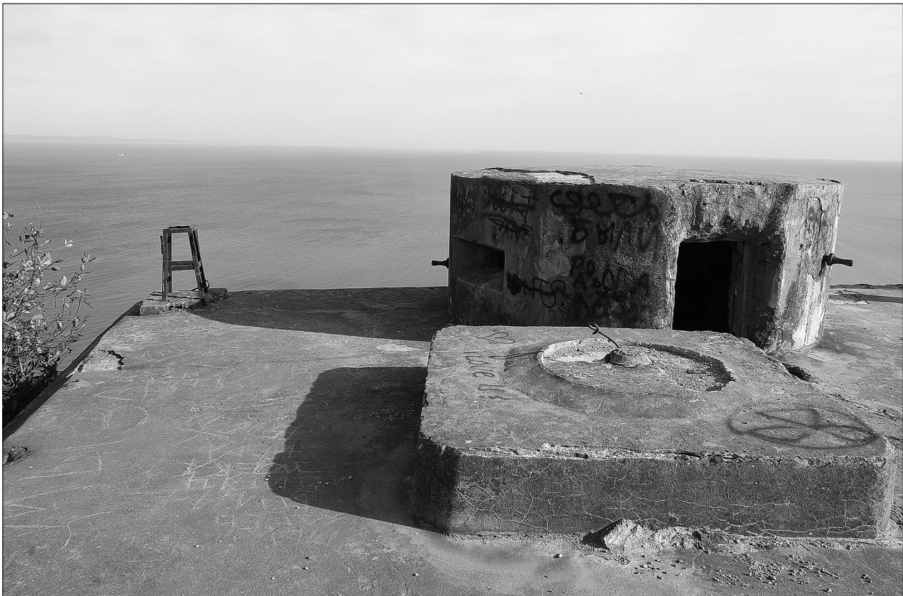
Батарея № 921. Командный пост. Рубка управляющего огнем и площадка для гальномера. Фото Ю.В. Иванова
