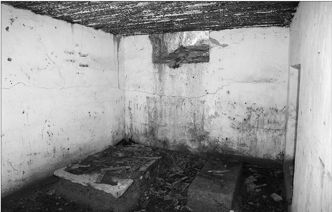
Батарея № 921. Правый погреб боезапаса. Окно для подачи выстрелов ко второму орудию. Фото Ю.В. Иванова
