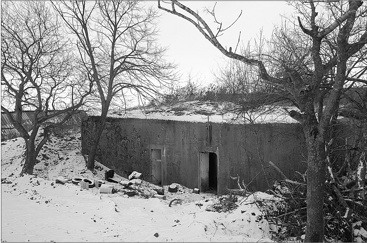
Батарея № 921. Погреб боезапаса на левом фланге (новый). Фото Ю.В. Иванова
